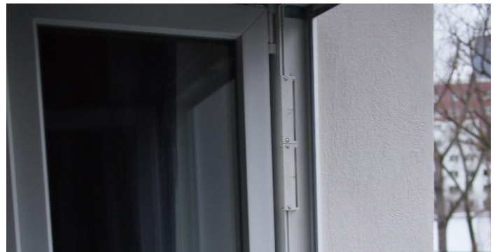
Abbildung 61: ALD als Fensterfalzlüfter, Quelle linke Abbildung ift Rosenheim
