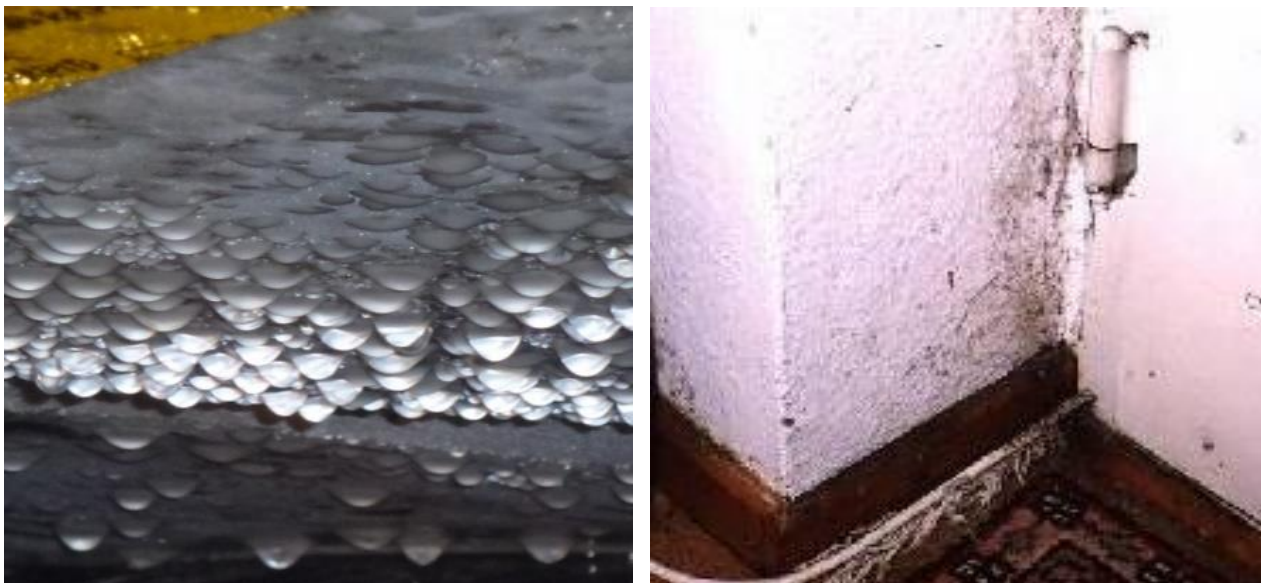
Abbildung 11: Für Schimmelwachstum wird nicht Wasser in flüssiger Form benötigt (linkes Foto), sondern es reicht eine (nicht sichtbare) erhöhte relative Feuchte aus und ein Nährstoffboden muss vorliegen
