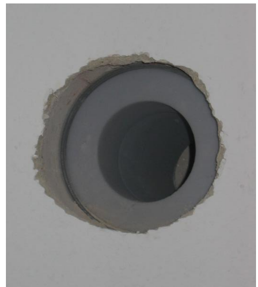
Abbildung 30: Konfliktsituation beim innerstädtischen Wohnen und kontinuierlichen Lüften über Fenster - Lösungsmöglichkeit über Außenbauteil-Luftdurchlass mit schallabsorbierender Einlage
