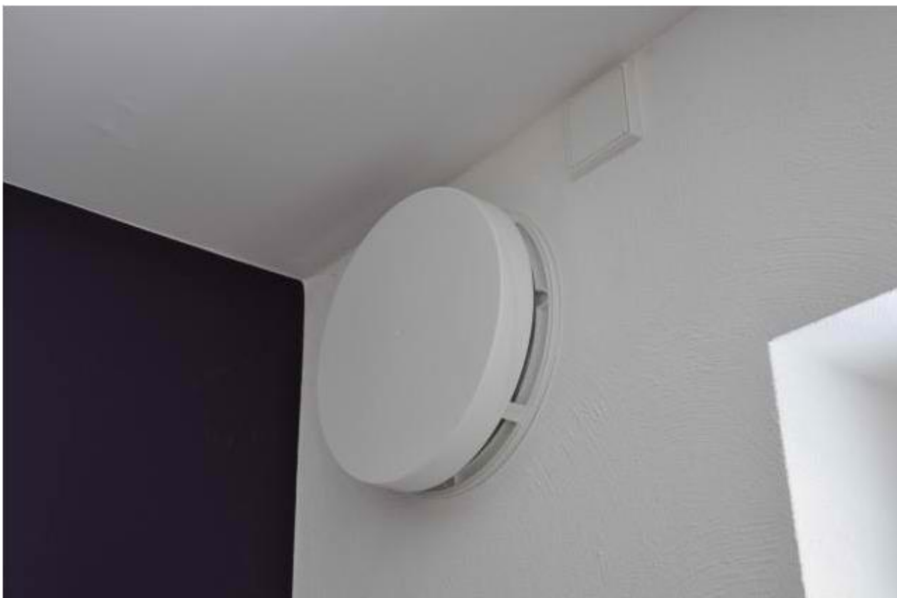
Abbildung 68: Paarweise arbeitendes dezentrales Zu-/ Abluftsystem, Quelle: FLiB e.V
