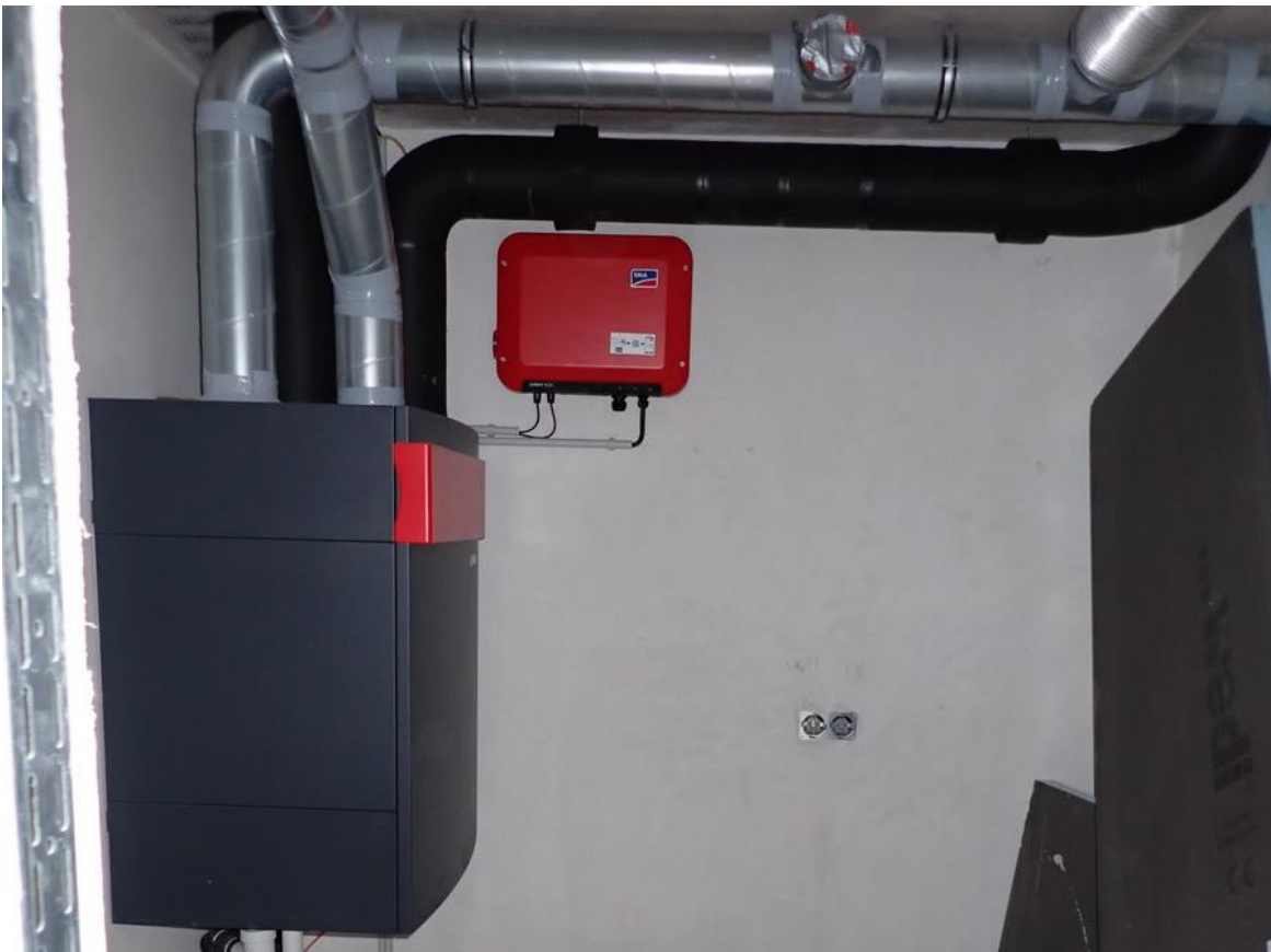
Abbildung 25: Wohnungszentrales Zu- / Abluftsystem mit Wärmerückgewinnung
